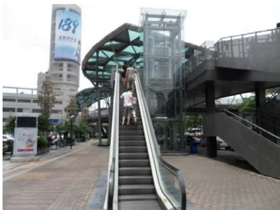
图 4.18 过街天桥缺乏自行车过街设施
