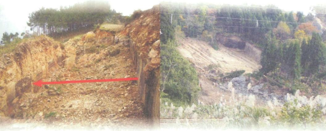
基岩顺层滑坡后拉开的裂缝
