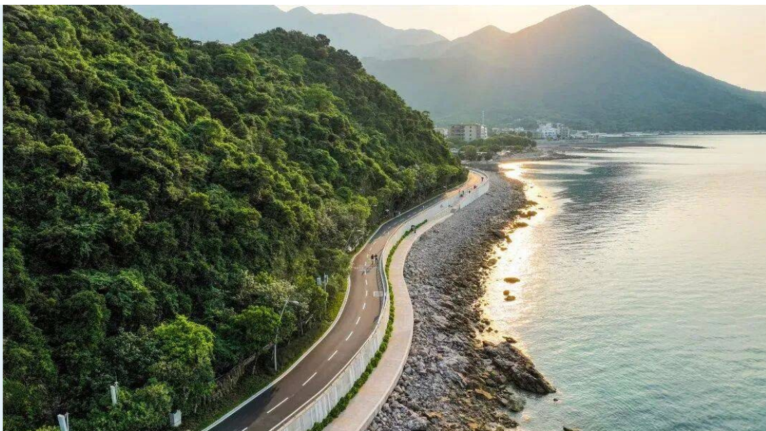
图12 东部海堤重建工程（三期）杨梅坑段
