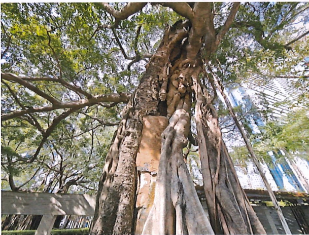
图 4-6 水泥修补面破损
