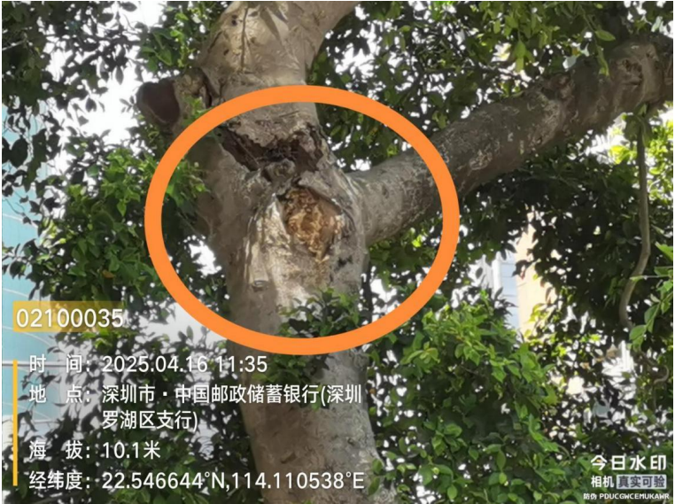
图 36 古树树干 8 米处具有折断风险处现状照片
