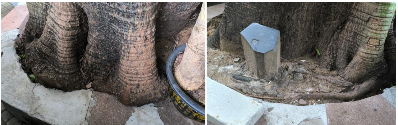
图 59 古树树根现状照片
