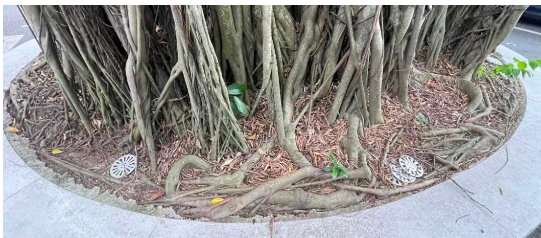
图 75 0037 号古树根系已盘树池内部现状照片
