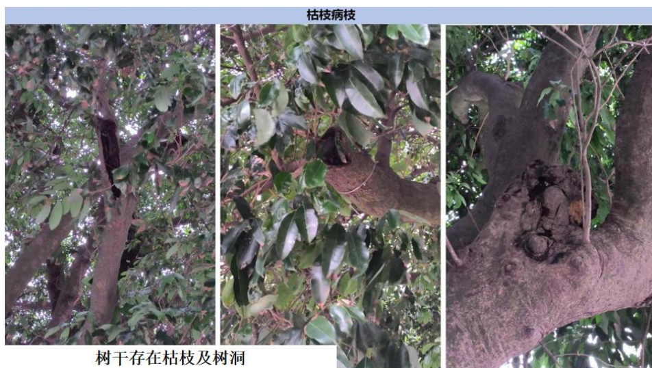
图 28 古树枝干现状照片
