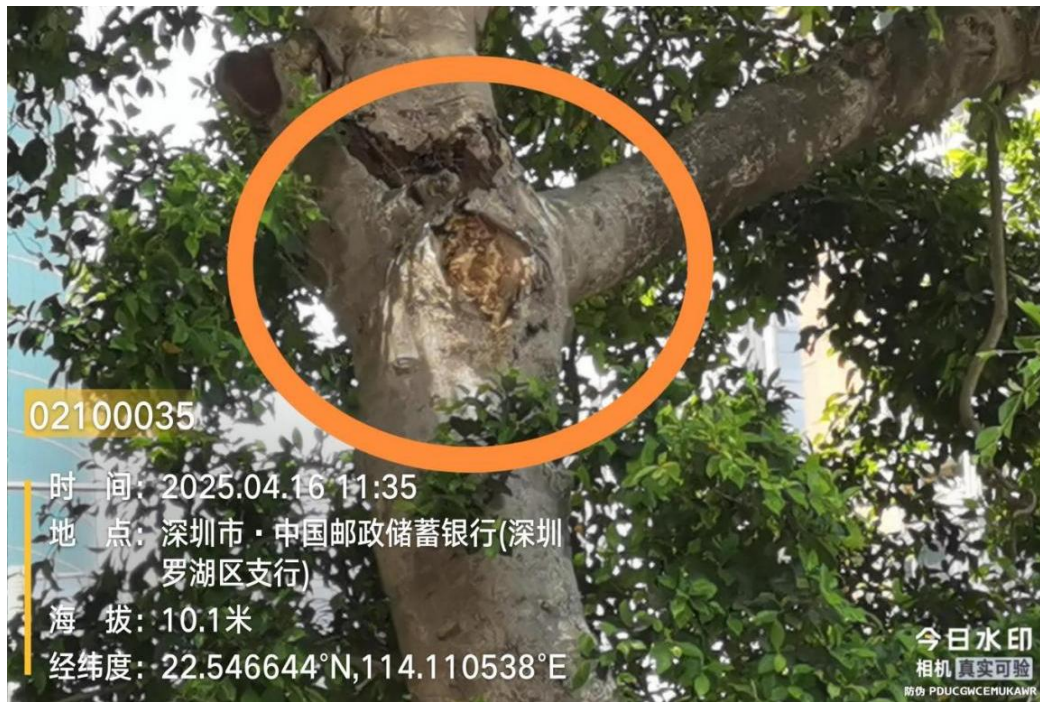
图 109 0035 号古树 8 米安全隐患点照片
