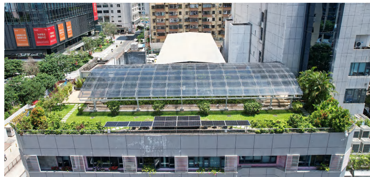
福田供电局近零碳示范区改造：天台上，可透光膜光伏组件为建筑提供绿色电能
