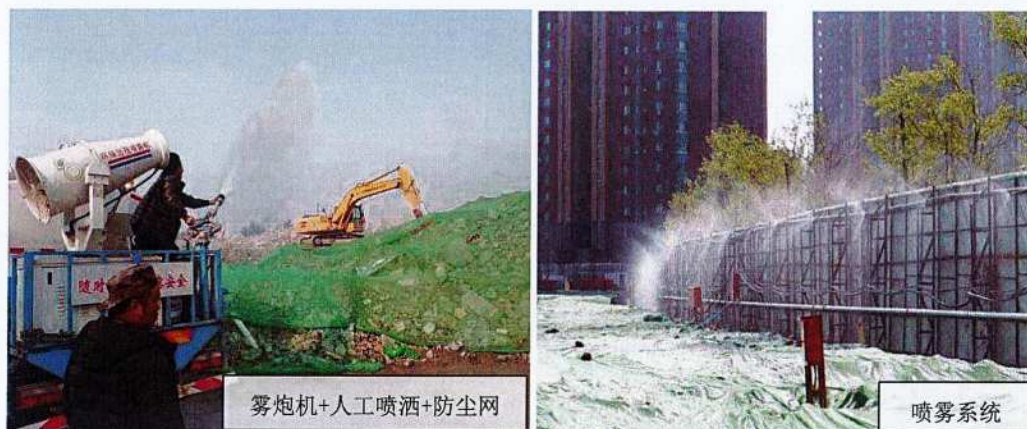
图 6-8 施工场地内除尘
