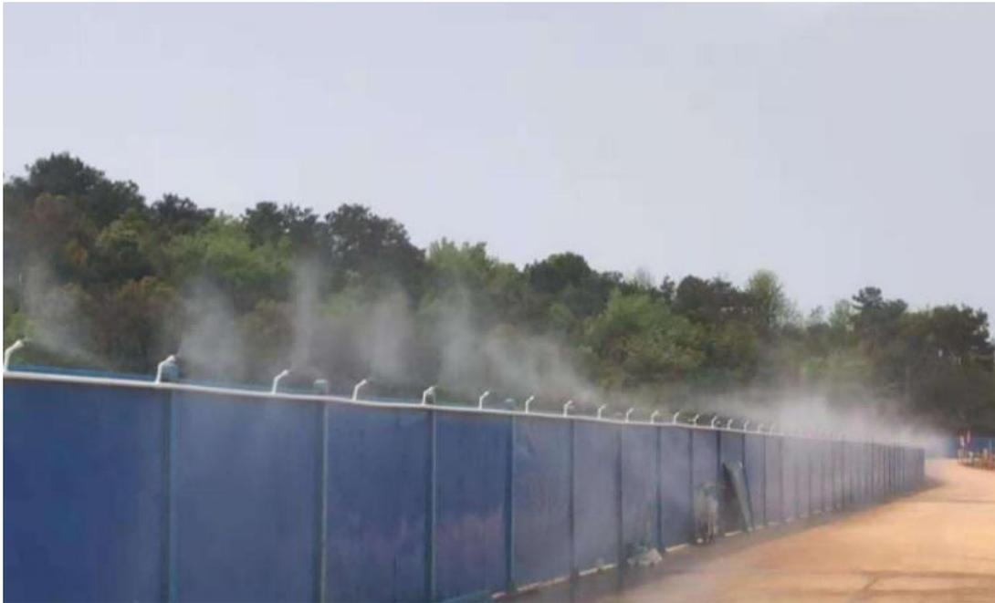
图 5-4 围挡喷淋系统示意图
