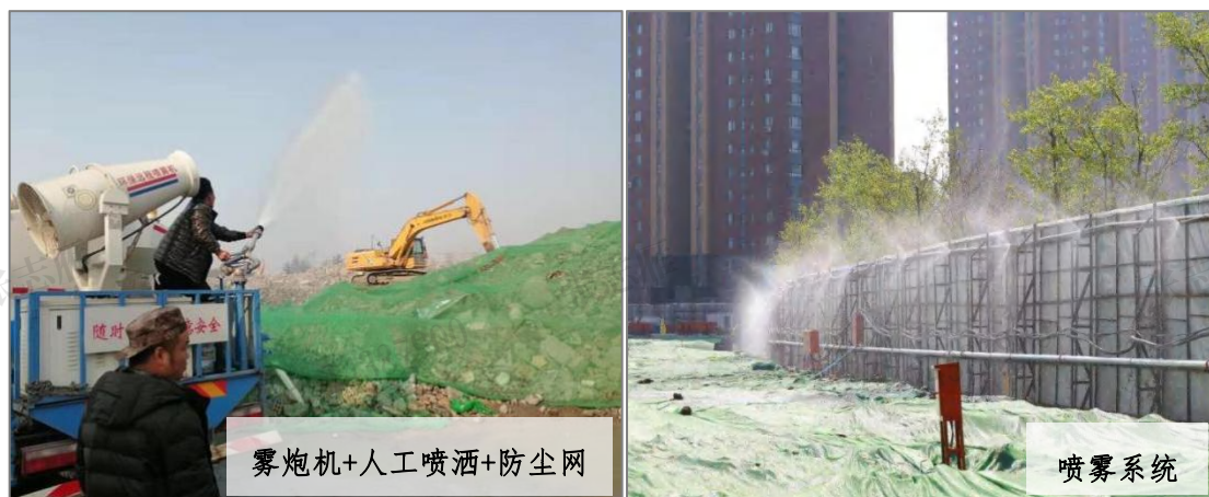
图 5.3 施工场地内除尘
