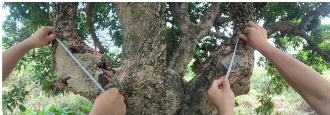
图 3.34 0085 号古树树洞现状照片
