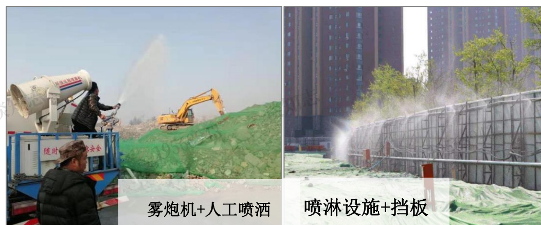
图 6.4 施工场地内除尘
