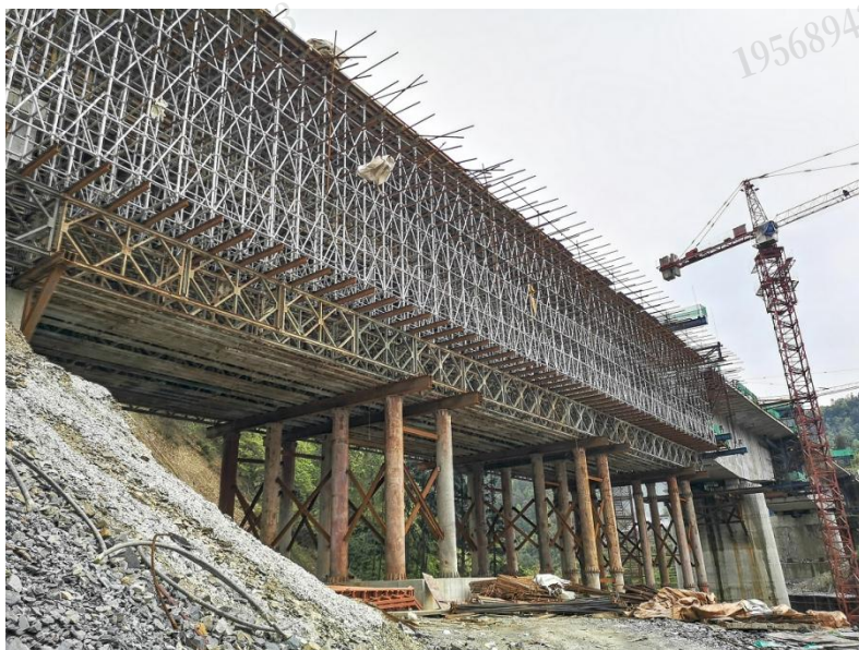
图 5.5 桥梁梁部支架现浇施工方式示意图
