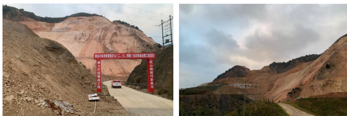
图 9 正在施工的新山片区历史遗留矿山生态修复治理工程（二、三、四期）
