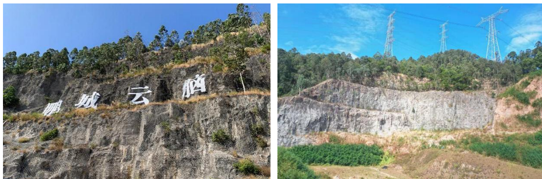
图 1 米坑石场（左）和盲婆坑石场（右）治理后的边坡现状
