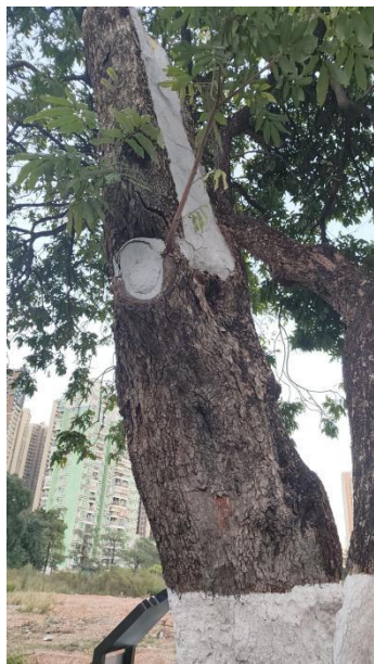
古树树洞现状
