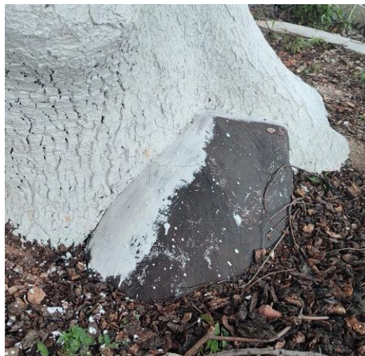
古树树洞现状
