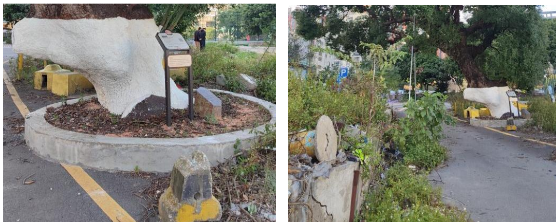
树池外为沥青密封铺装
