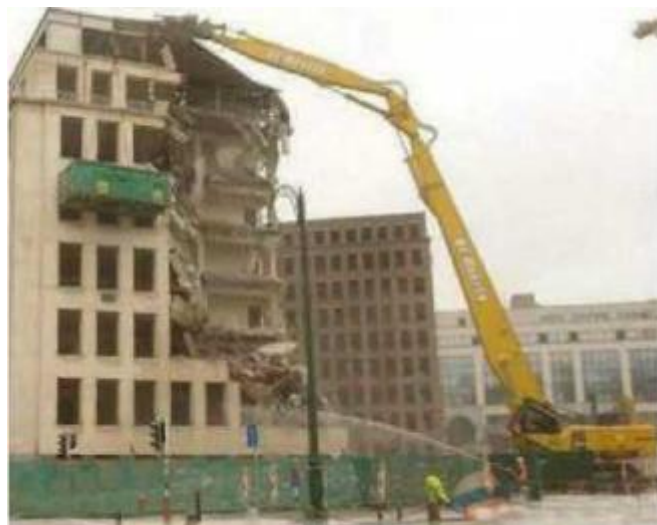
图 3-8 长臂炮机拆除作业
