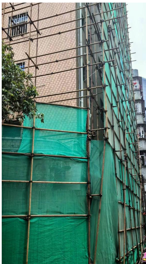
图 5-5 施工断面围蔽
