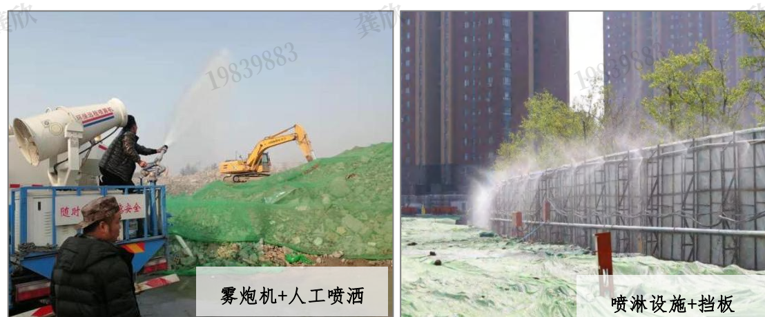
图 4.2 施工场地内除尘
