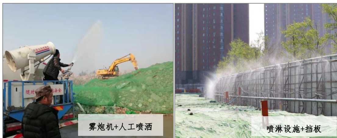
图 4.5 施工场地内除尘
