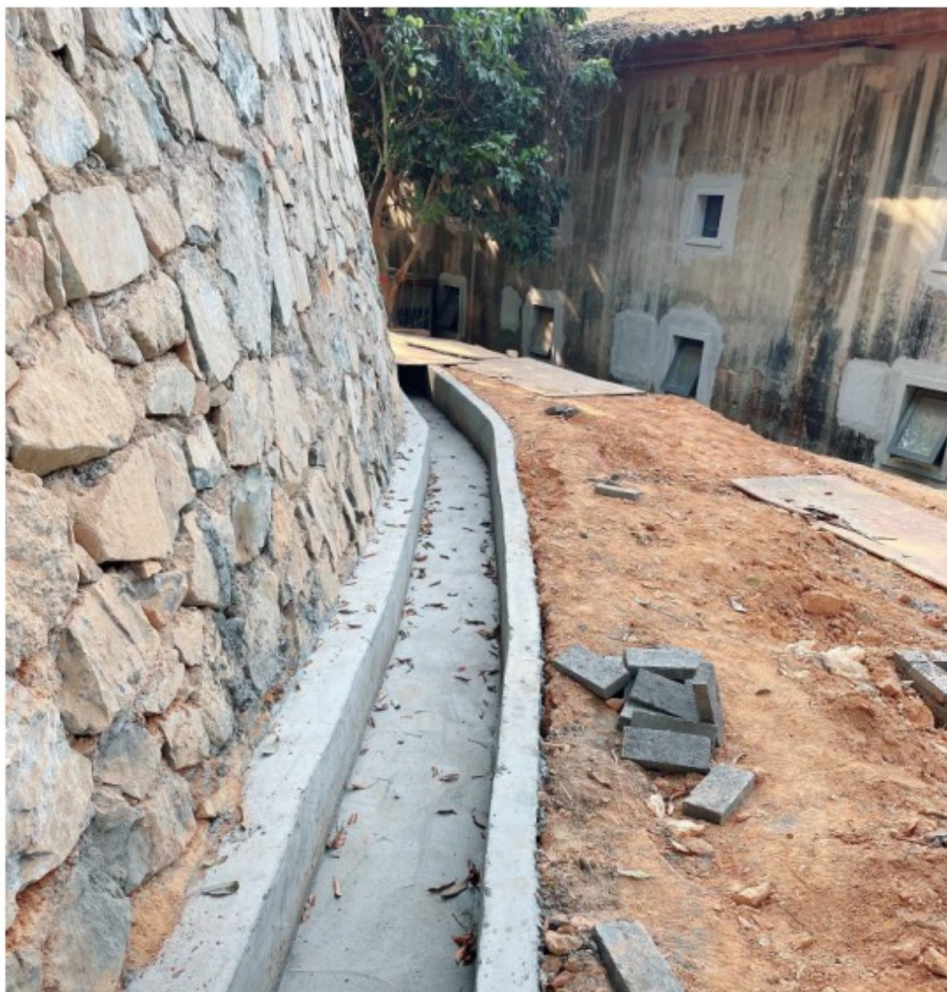
图 4-4 现状排洪沟修缮
