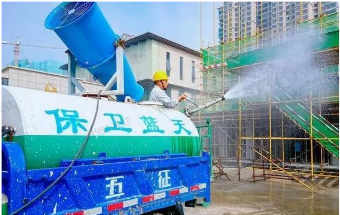
图 3.18 施工场地内除尘
