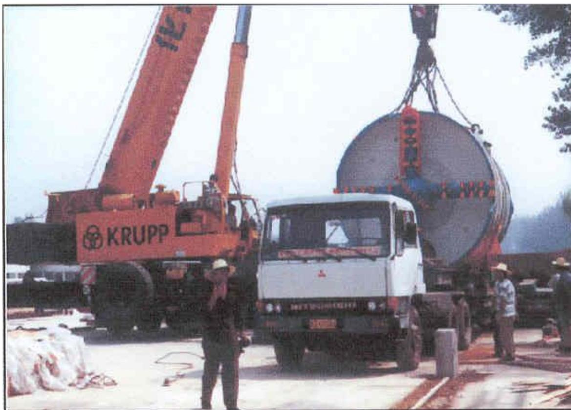
图 2.3-8 盾构机头吊运实际示意图
