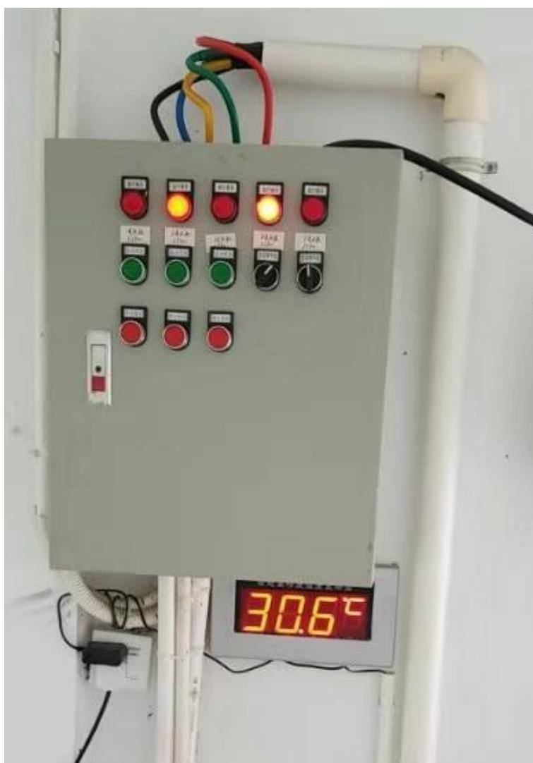
图 1-4 废水自动测温设备
