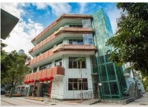
福田区园岭八角楼托养中心
