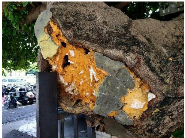
修补面破裂（东侧，1.5m 处）
