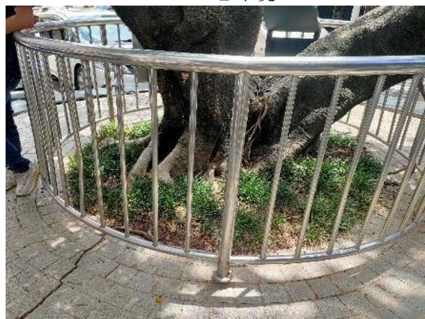
树池内硬地化铺装
