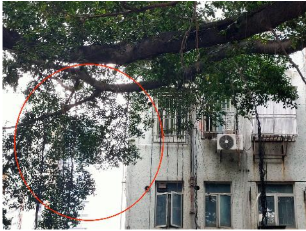
适当修剪小区上方的下垂枝（西南侧，6m 处）
