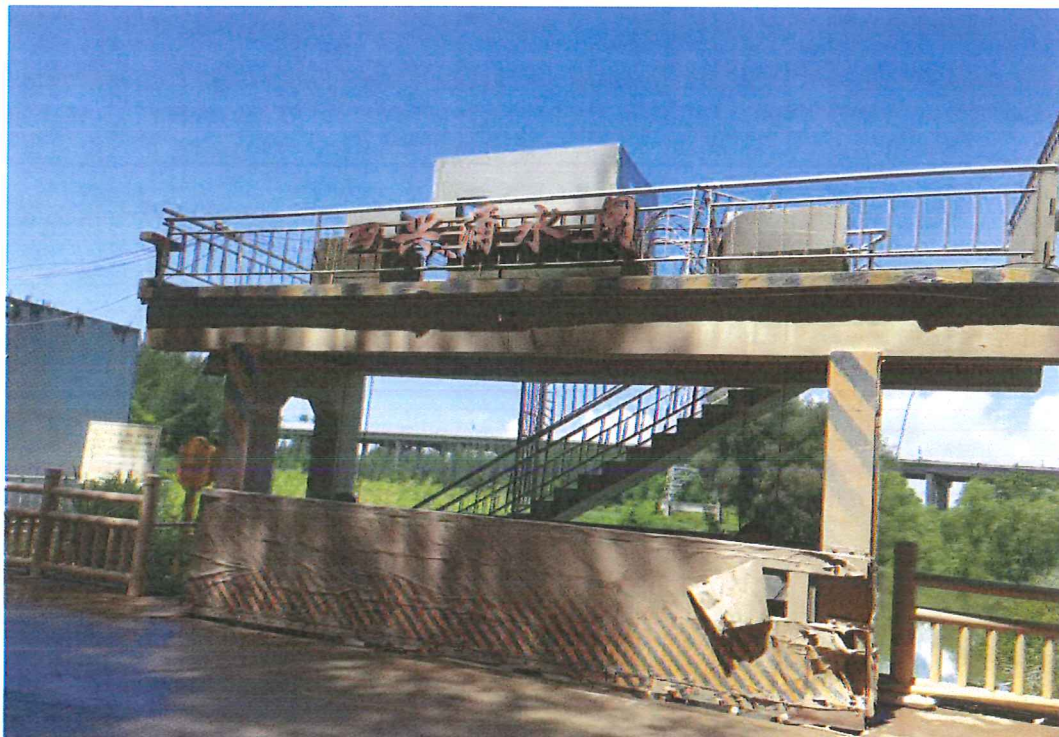
图 3.4-7 项目东南侧四兴涌水闸现状照片
