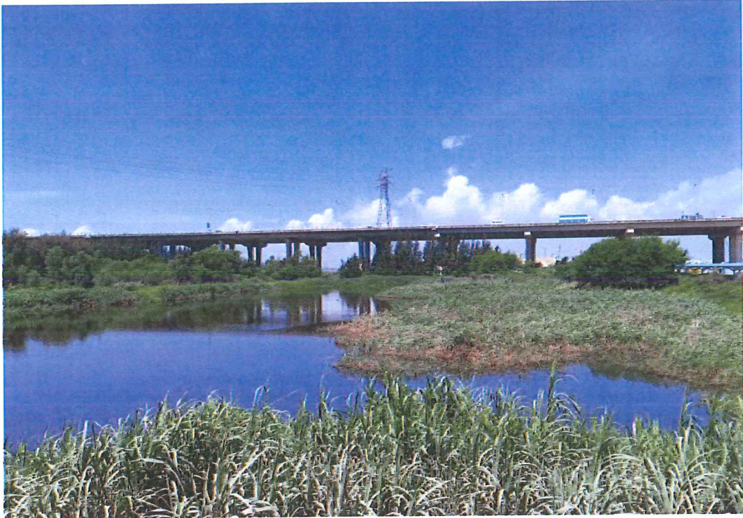
图 3.4-8 项目东侧广深沿江高速公路（深圳段）项目现状照片
