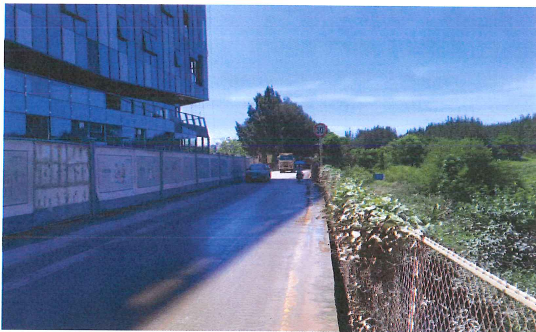
图 3.4-4 项目东侧西海堤现状照片
