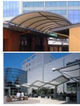
构、建筑物间的遮阳避雨设施
