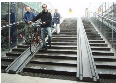
图 7.4.5-3 设置半圆形凹槽的自行车推行坡道
