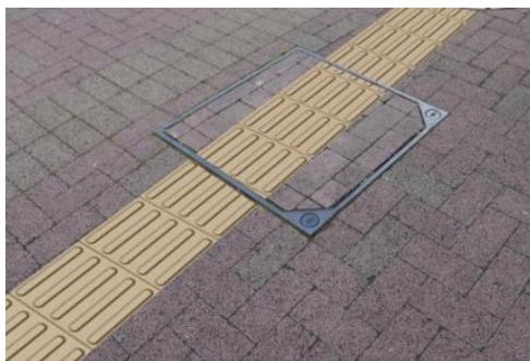
图 5.4.5-4 盲道不用绕行检查井盖
