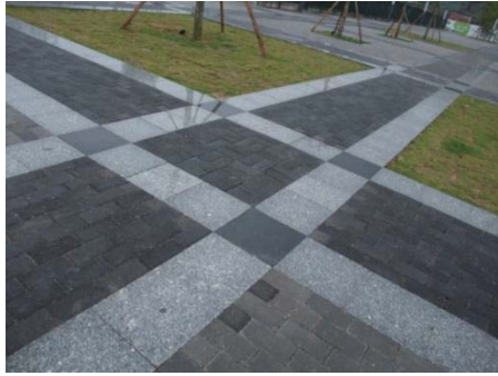
透水铺装地面
